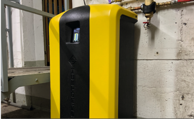
Der Vakuumentgaser SpiroVent Superior S600 entzieht dem Systemwasser gelöste Gase
