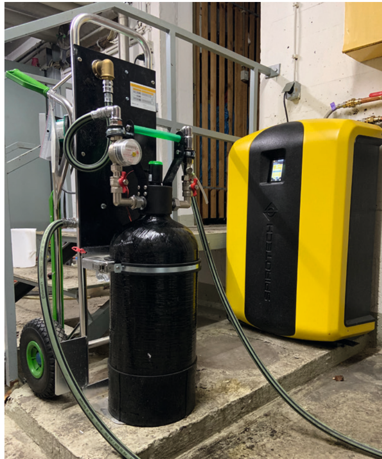
Die mobile SpiroPure ProFill, vor dem Vakuumentgaser, bringt das Anlagenwasser auf das gewünschte Niveau, gemäß VDI 2035
